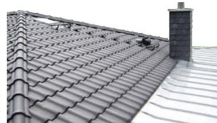
Auch aufwendige Speziallösungen wie diese Zink-Doppelstehfalzdeckung in Woltersdorf gehören zum Leistungsprofil.
