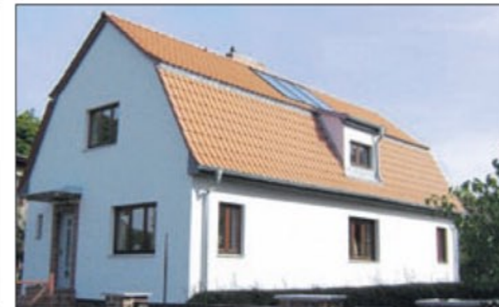
Dieses Einfamilienhaus steht in Berlin-Adlershof und wurde kürzlich von der Dachdeckerei Störmann modernisiert.
